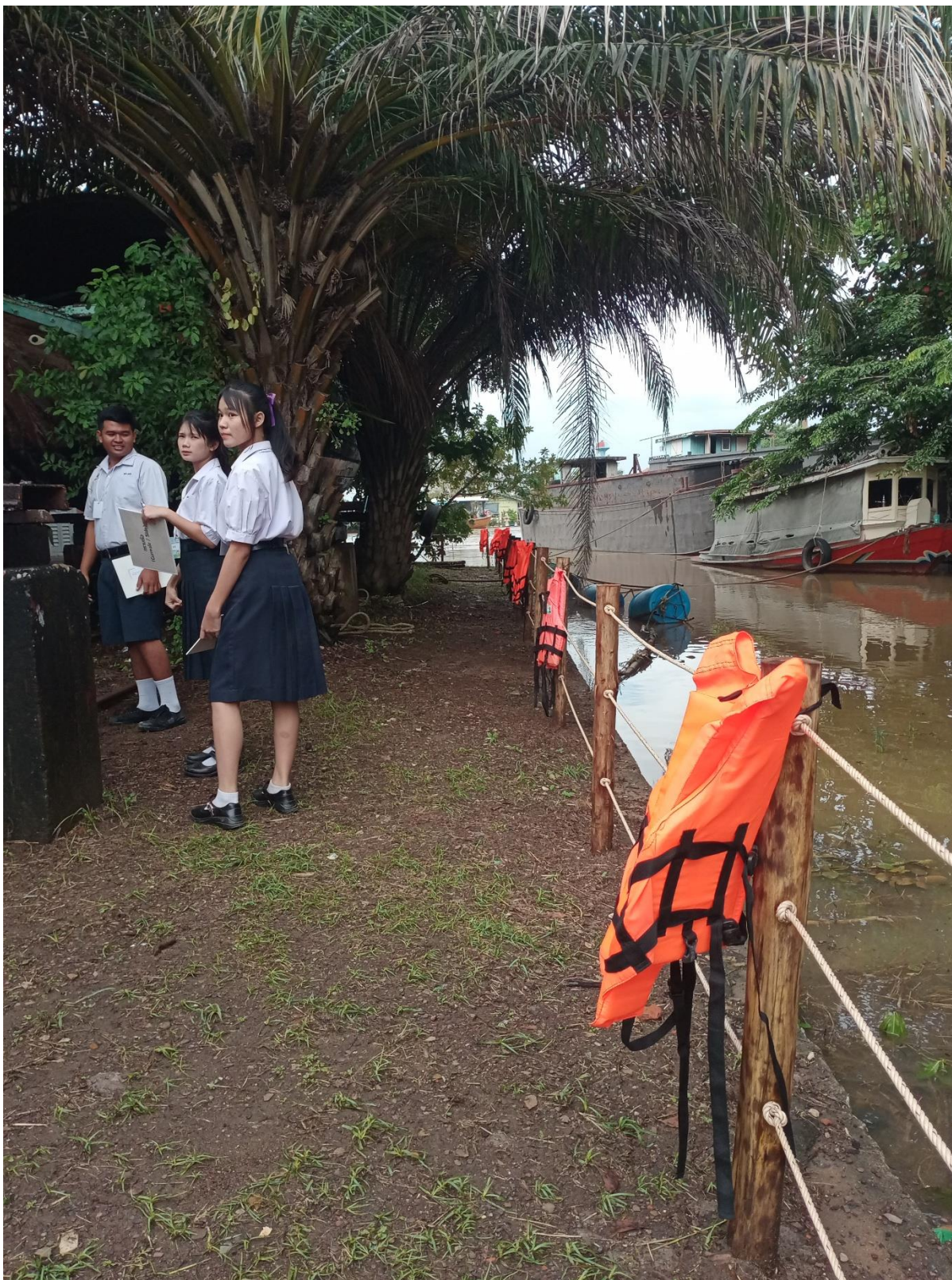
ภาพ การพัฒนาแนวกันตกริมน้ำ และติดตั้งอุปกรณ์ช่วยชีวิต เพื่อความปลอดภัย
