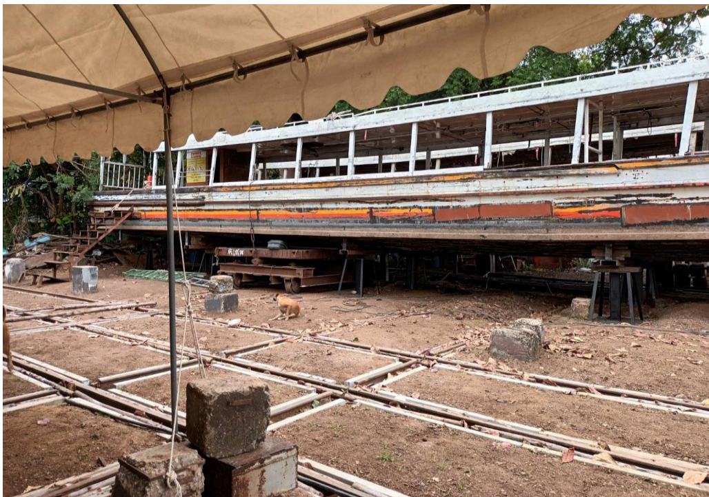
ภาพ การปรับปรุงพื้นผิวลานให้มีความเรียบเหมาะสมต่อการเดินและทำกิจกรรม โดยได้นำไม้ยางพารามาวางตามแนวร่อง slip way เพื่อลดโอกาสการเดินตกร่องจนเกิดอุบัติเหตุ
